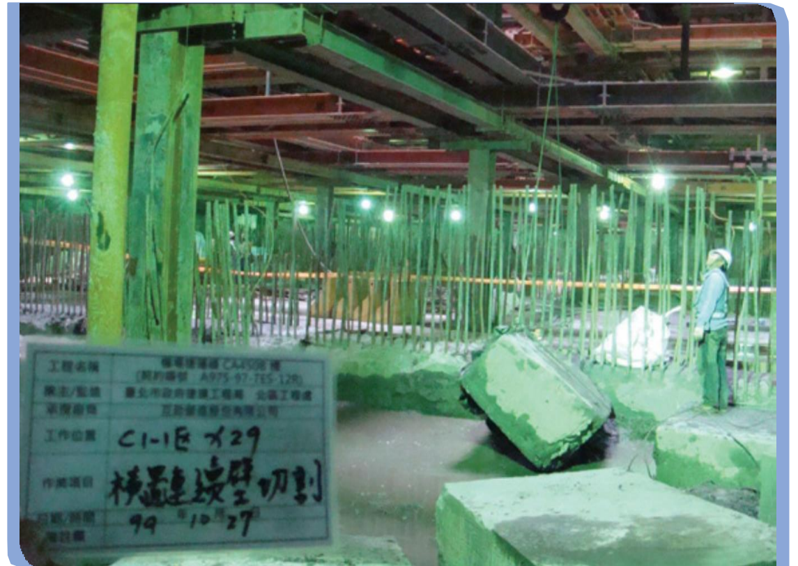
混凝土塊吊離照片
