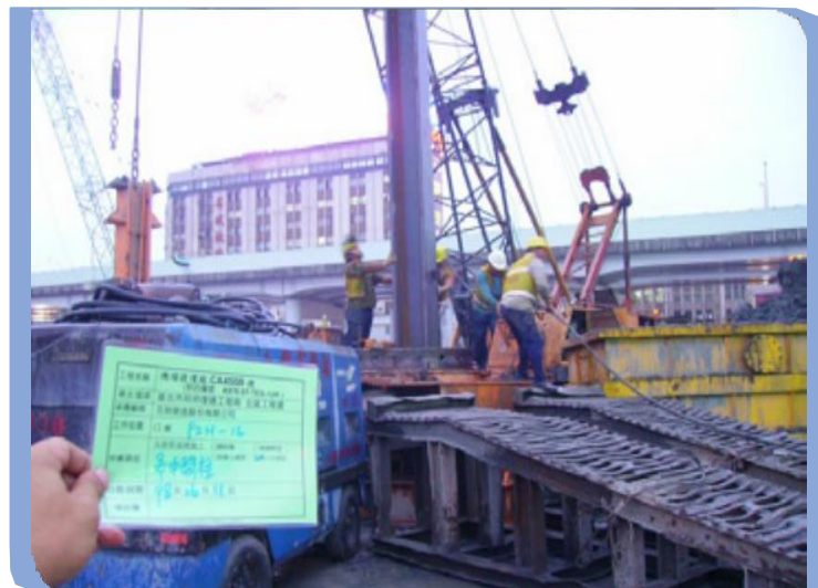
基樁混凝土澆置完成，主體開挖支撐系統—中間柱型鋼吊放插入混凝土
