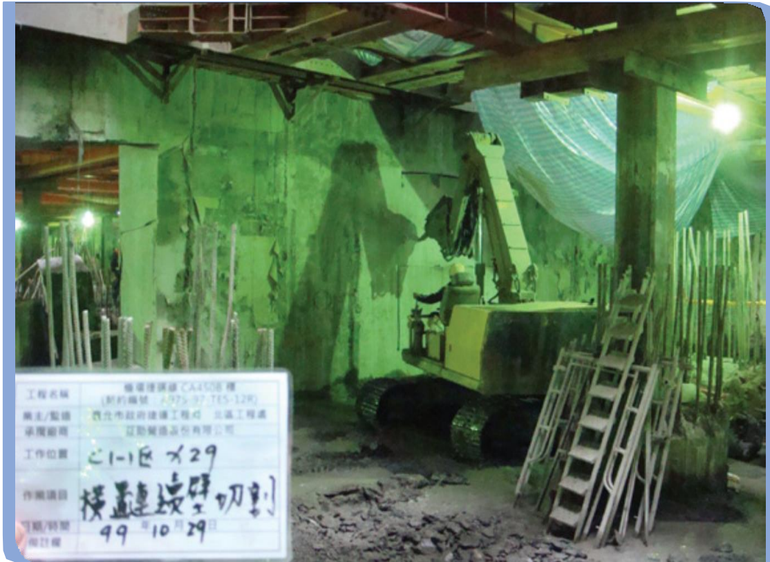
混凝土塊推出照片
