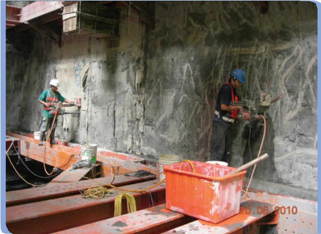
切割前引孔照片
