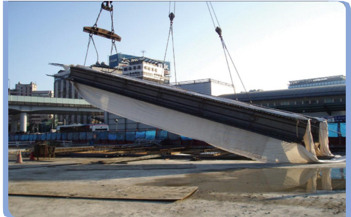
三點吊法吊放鋼筋籠施工照片
