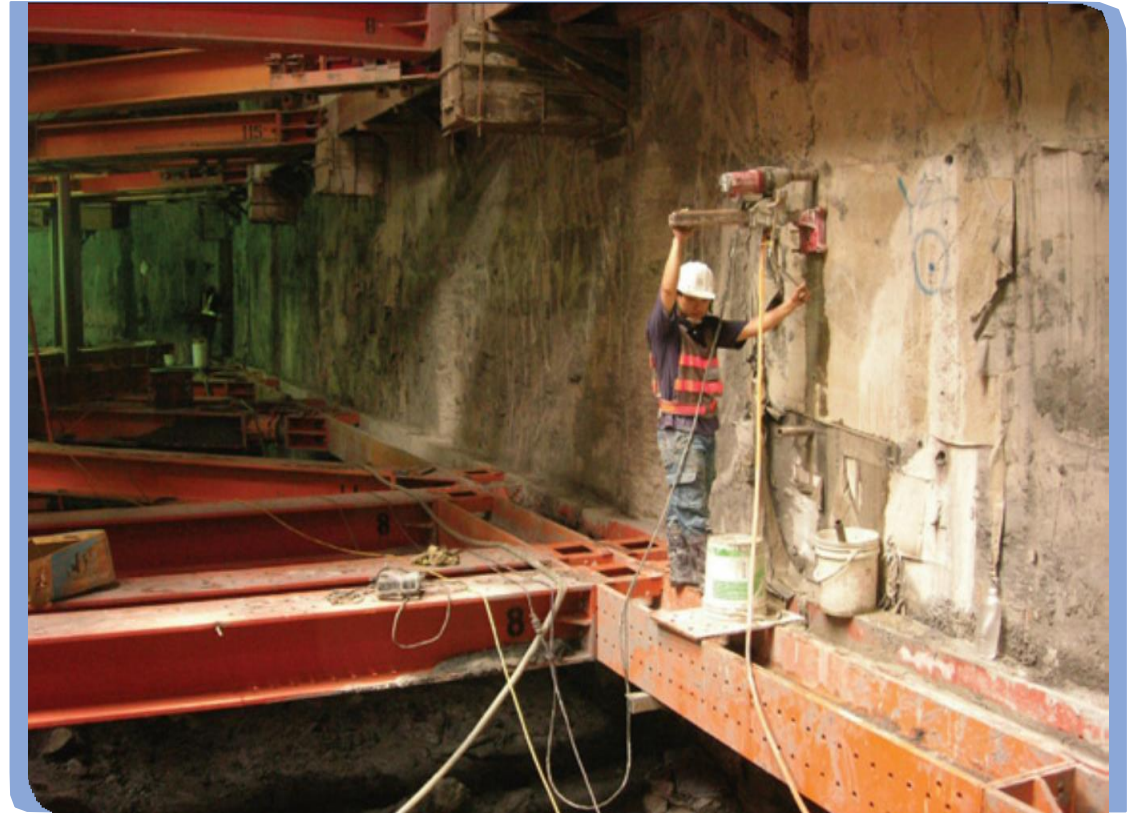
切割前引孔照片
