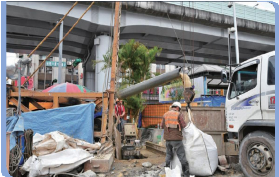
景美層抽水井鑽掘
