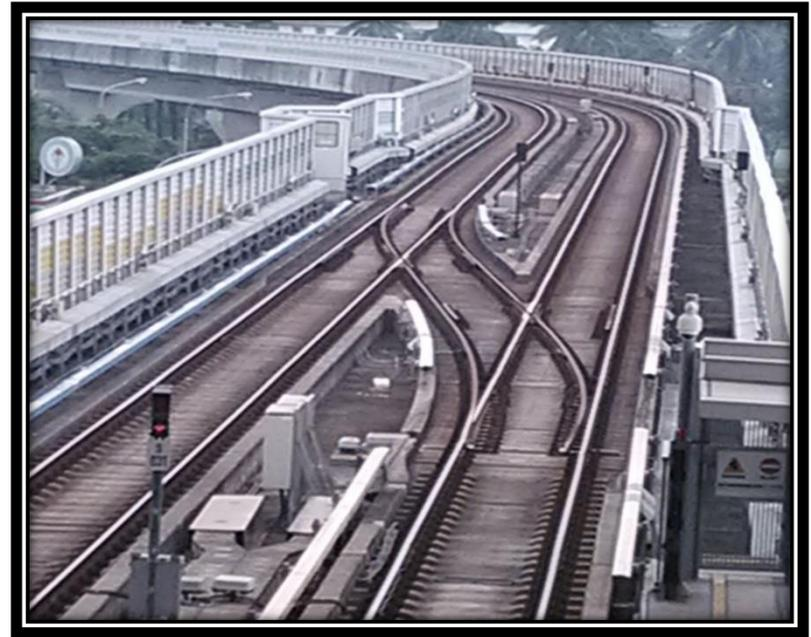
高架段一般車站為側式月台，配合橋面板寬度以配置兩組單橫渡線結構成本低且設置位置彈性大，故建議可配置可動式岔心
